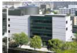
南・西壁面に設置された太陽光パネル
