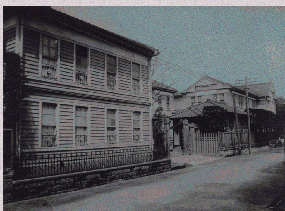
大正期の寄宿舎外観の一部
